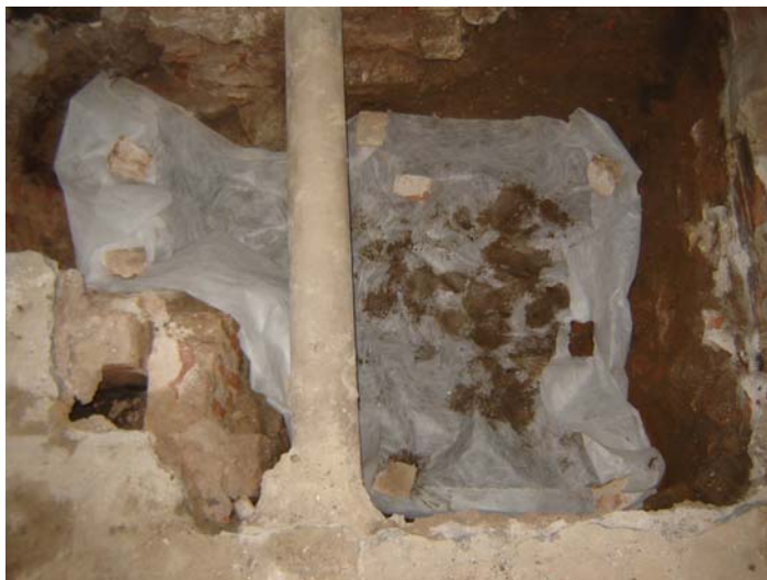
Fotografia final amb el geotèxtil.
