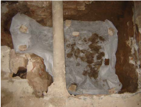
027. Fotografia final amb el geotèxtil.
