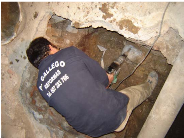
Fotografia del desmuntatge de la UE 110 i UE 111.
