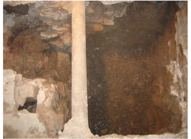
026. Fi desmuntatge UE 110 i UE 111.
