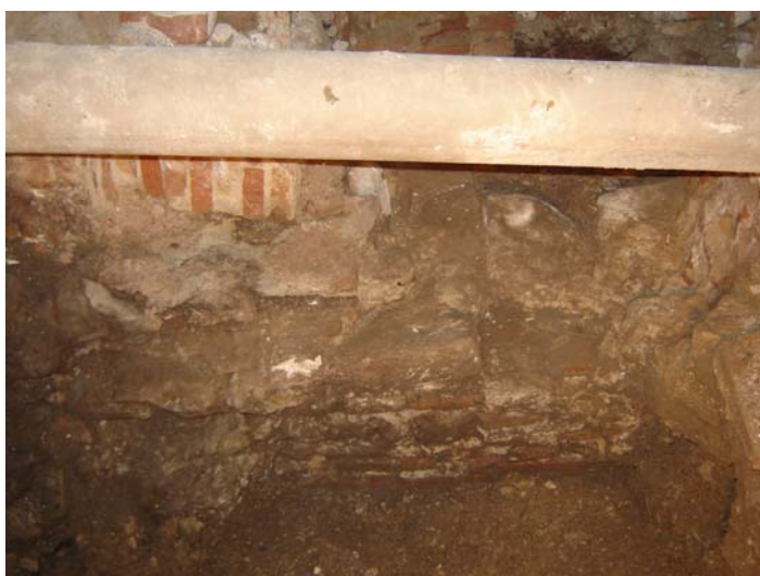
Fotografia del perfil de les UE 110 i UE 111
