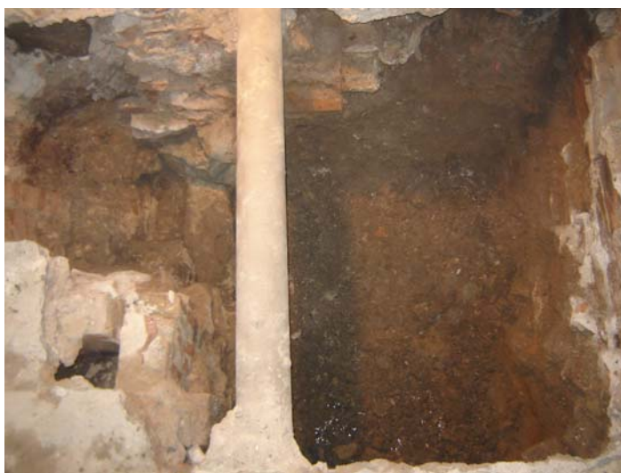
Fotografía final, una vegada assolida la cota necessària, 1,5 m de profunditat (2,92 m.s.n.m).
